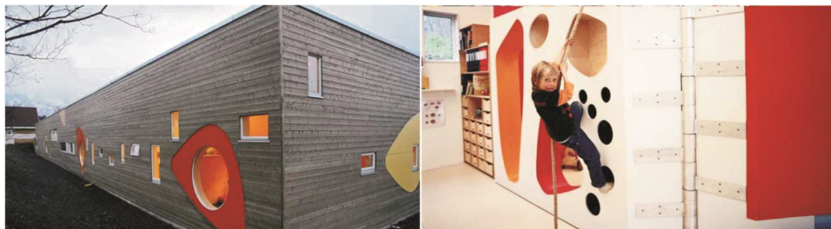
Zdjęcie 4,5. Przedszkole w Troms (Norwegia) i przypadkowo rozmieszczone okna oraz „wspinaczkowe” ściany [10].
